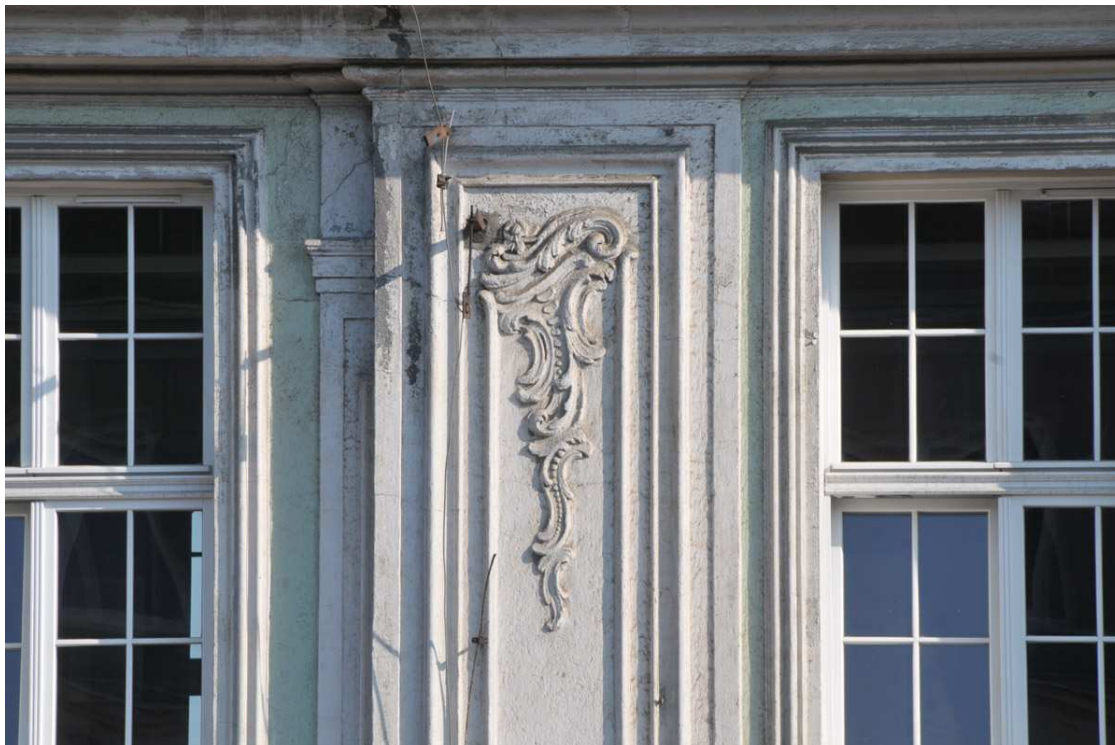
Rysunek 10 - Przerwa w ciągłości przewodu odprowadzającego
