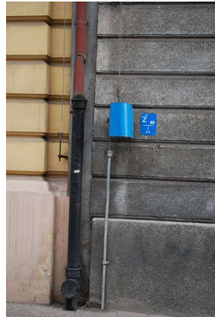
Rysunek 3-Przewód odprowadzający w postaci taśmy stalowej
