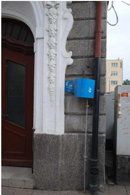
Rysunek 2-Przewód odprowadzający w postaci pręta
