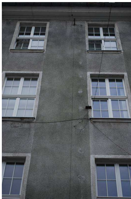
Rysunek 5-Mocowanie przy pomocy naciągu
