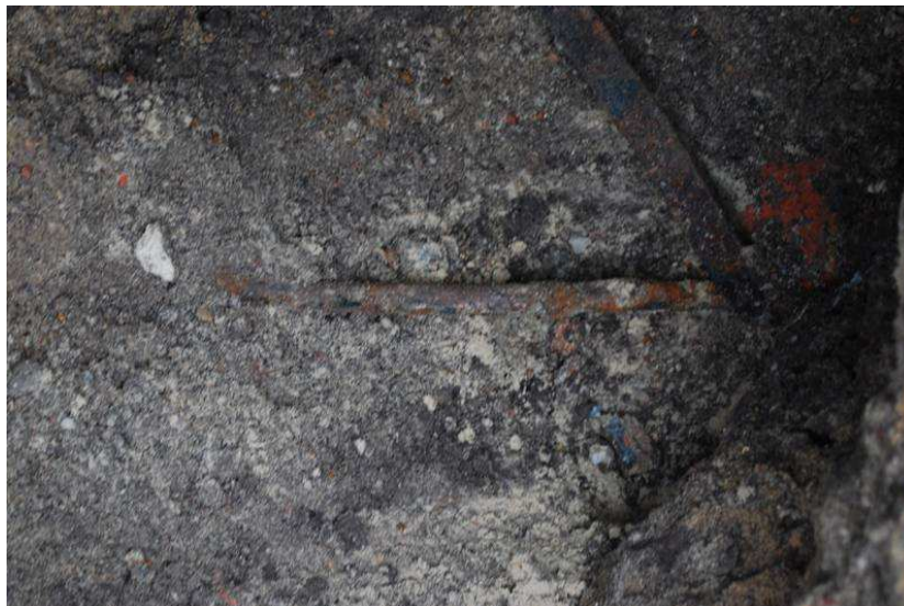
Rysunek 1 – uziom otokowy istniejący
