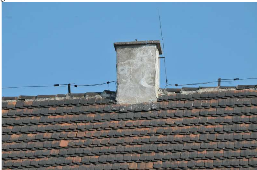
Rysunek 7-Zwody poziome na dachu
