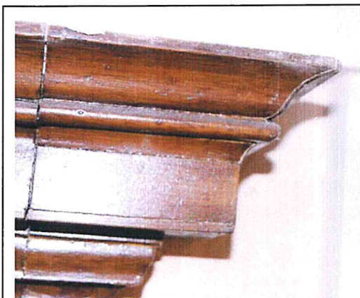
fot. 9 Detal – profil gzymsu naczółka.
