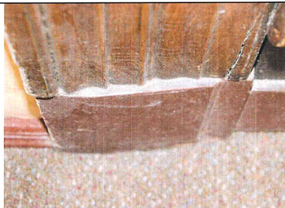
fot. 10 Detal – profil listwy maskującej.
