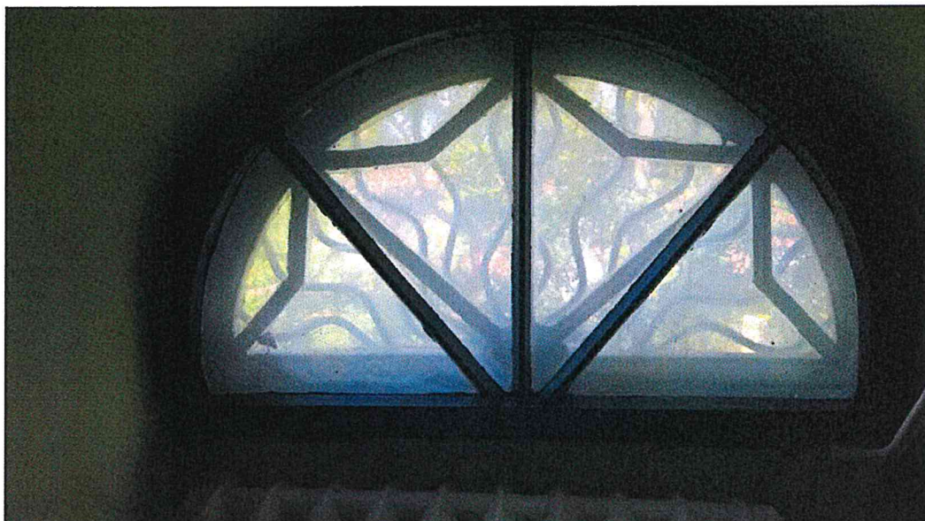
Fot. 1 – okno poddasza na elewacji północnej
