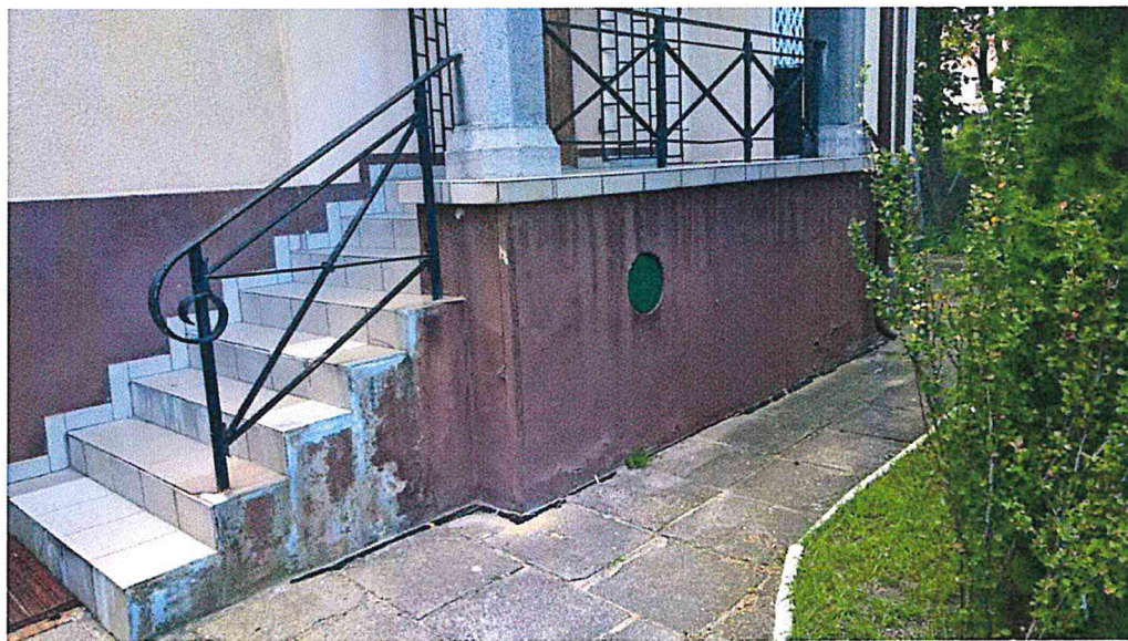
Fot. 16 – dolna część ganku
