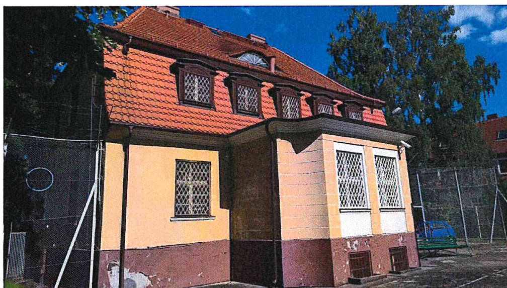
Fot. 12 – elewacja zachodnia – widok ogólny
