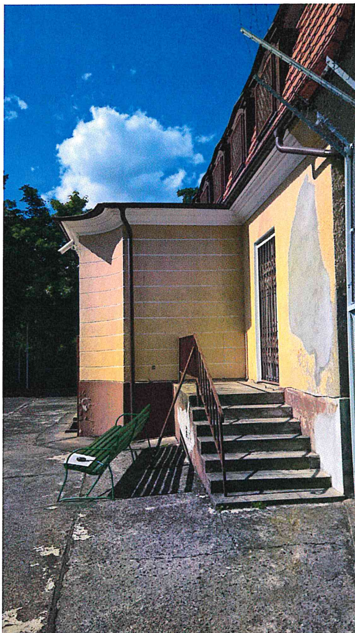
Fot. 21 – tylne wejście do budynku
