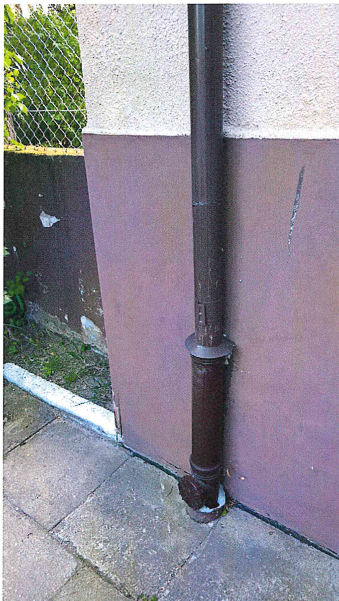
Fot. 22 – rura spustowa na elewacji frontowej
