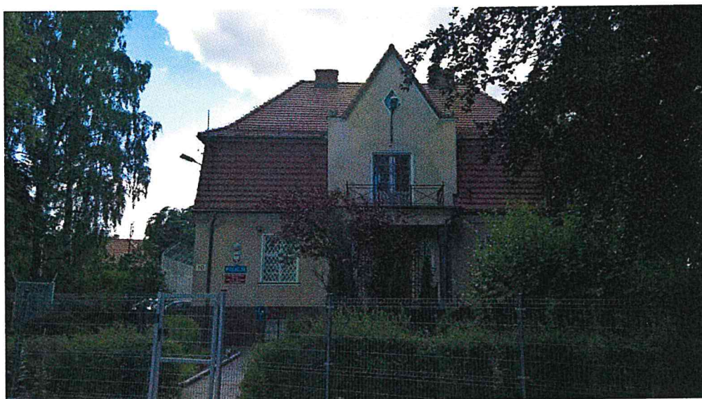
Fot. 13 – elewacja frontowa – widok ogólny
