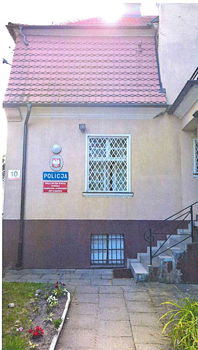
Fot. 8 – elewacja wschodnia – południowy narożnik
