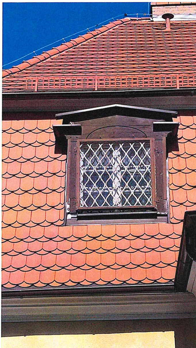
Fot. 19 – lukarna na elewacji zachodniej
