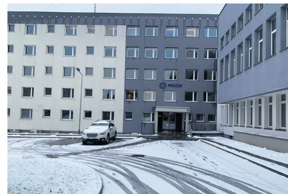
Budynek KMP Słupsk
